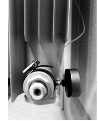
Используется хомут диаметром 45 мм
